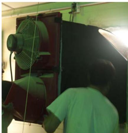
Es más, los aparatos se ensucian menos por hallarse fuera, y sólo requieren el soplado con aire comprimido para su mantenimiento. Sin embargo, no hay que dejar de lado la importancia de su forma de gestión: el ordenador de control hace trabajar a los calefactores cíclicamente para evitar el riesgo de estratificación térmica típico del trabajo a sobrepresión.
